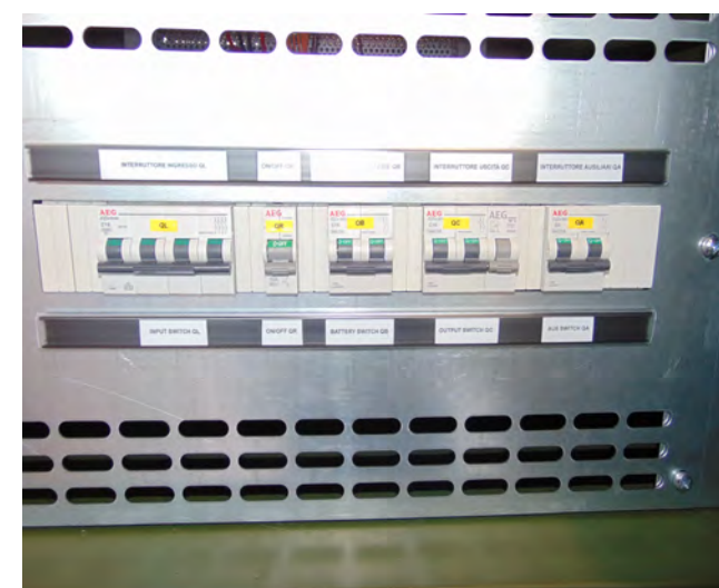
Siglatura ed identificazione componenti Components labeling and identification
