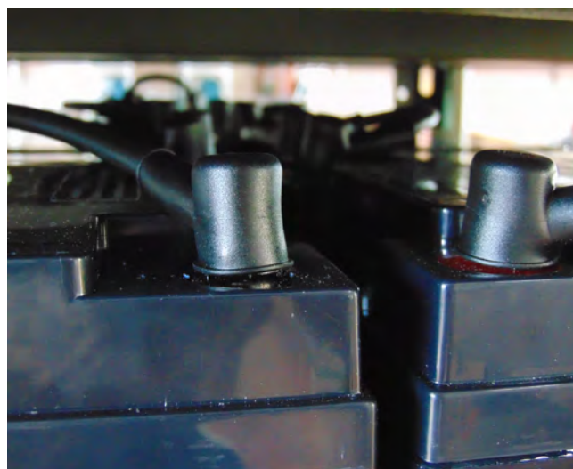
Poli batteria isolati contro i contatti accidentali Battery poles insulated against accidental contacts
