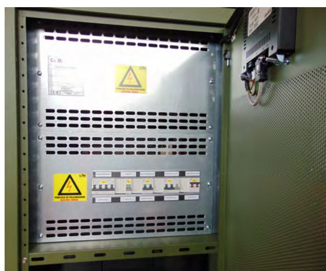
Segregazione metallica elettronica di potenza Metal segregation electronic power
