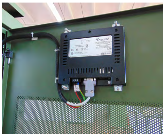
Connessione display con cavo schermato Display connection with shielded cable
