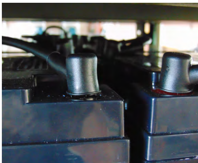
Poli batteria isolati contro i contatti accidentali Battee poles insulated against accidental contacts
